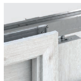
construcția casetei metalice sistem de glisare COMPACT
